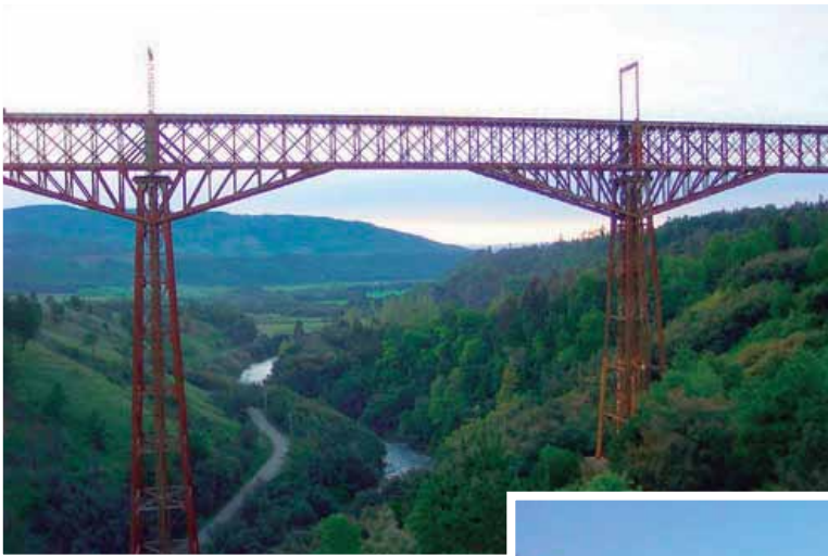
Viaducto del Malleco, Collipulli.
